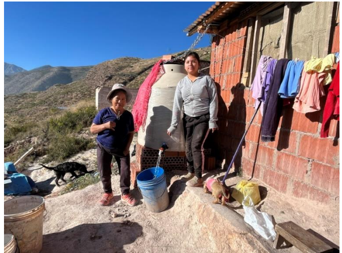
Tanque de agua fijo al lado de la vivienda que acabamos de llenar. Los 600 litros de agua alcanzan para casi un mes. Ahora las mujeres pueden lavar la ropa y bañarse de forma regular.
