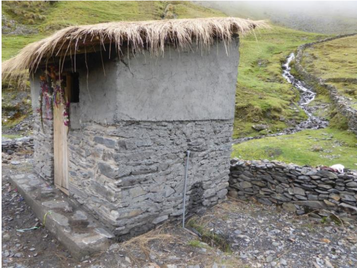
Wasseranschluss von aussen.
