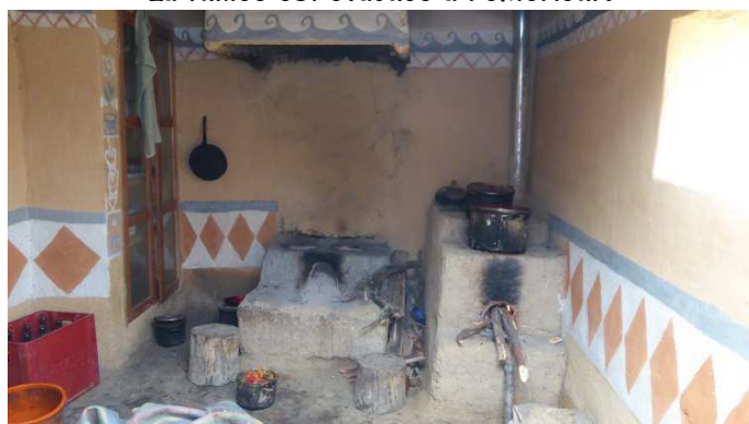
Four de cuisine amélioré avec une cheminée. La fumée est évacuée à l'extérieur.
