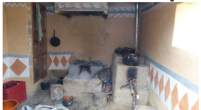
Neuer Küchenofen mit Abzugskamin und Gussrohr im Innern des Ofens. Der Rauch wird nach aussen geleitet.
